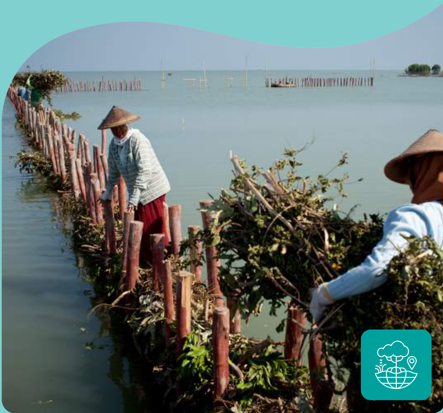
Grupos comunitarios construyen estructuras permeables para atrapar sedimentos en Demak (Indonesia) © Nanang Sujana
