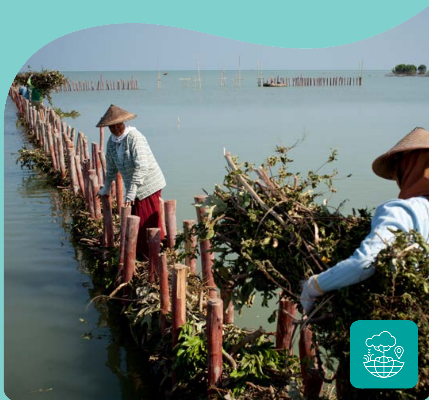
Grupos comunitários construindo estruturas permeáveis para reter sedimentos em Demak, Indonésia © Nanang Sujana
