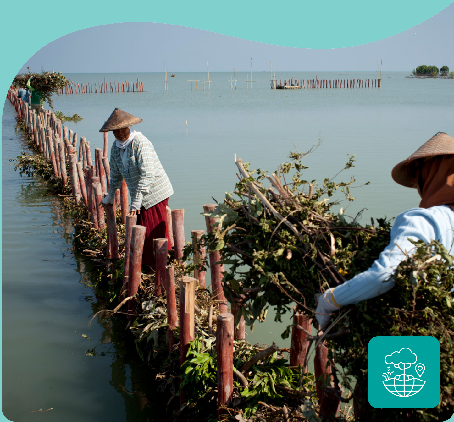
Des groupes communautaires construisent des structures perméables pour piéger les sédiments à Demak, en Indonésie © Nanang Sujana
